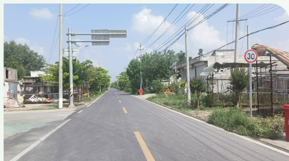
集团捐资为一里王村实施道路硬化项目
